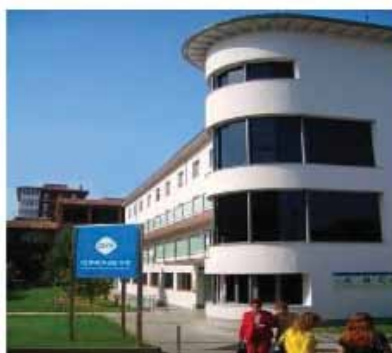
Vista del edificio A
