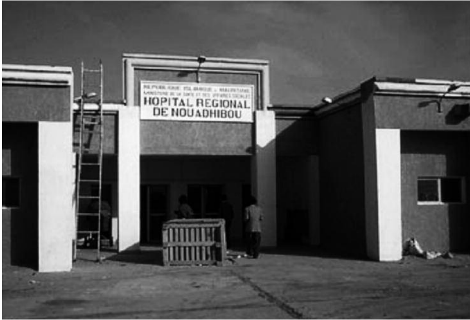
Fig. 9. Hospital de Nouadhibou
